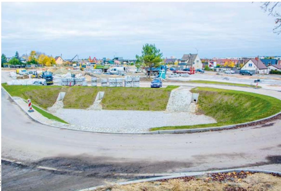
ZBIORNIK ROZSĄCZAJĄCY WODY OPADOWE, ZLOKALIZOWANY PRZY BUDOWANYM WĘZLE JANOWO
