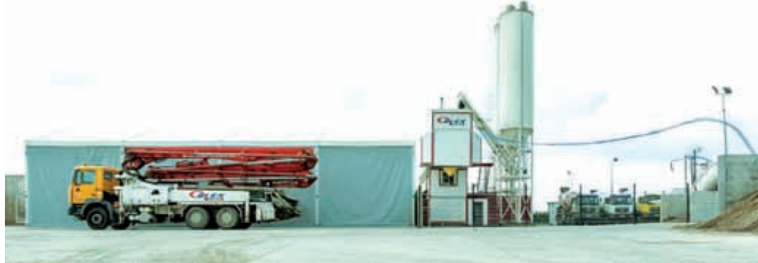
Jeden z najnowocześniejszych węzłów betonowych firmy Orlex Beton
