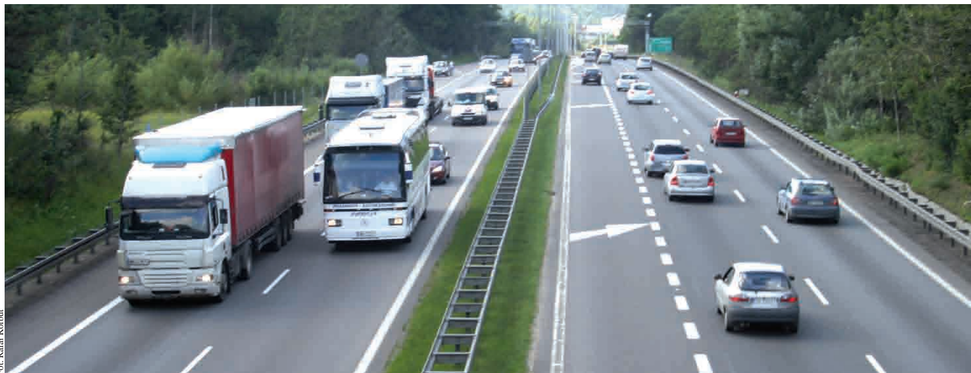
Budowa obwodnicy rozpocznie się najwcześniej w 2014 roku
