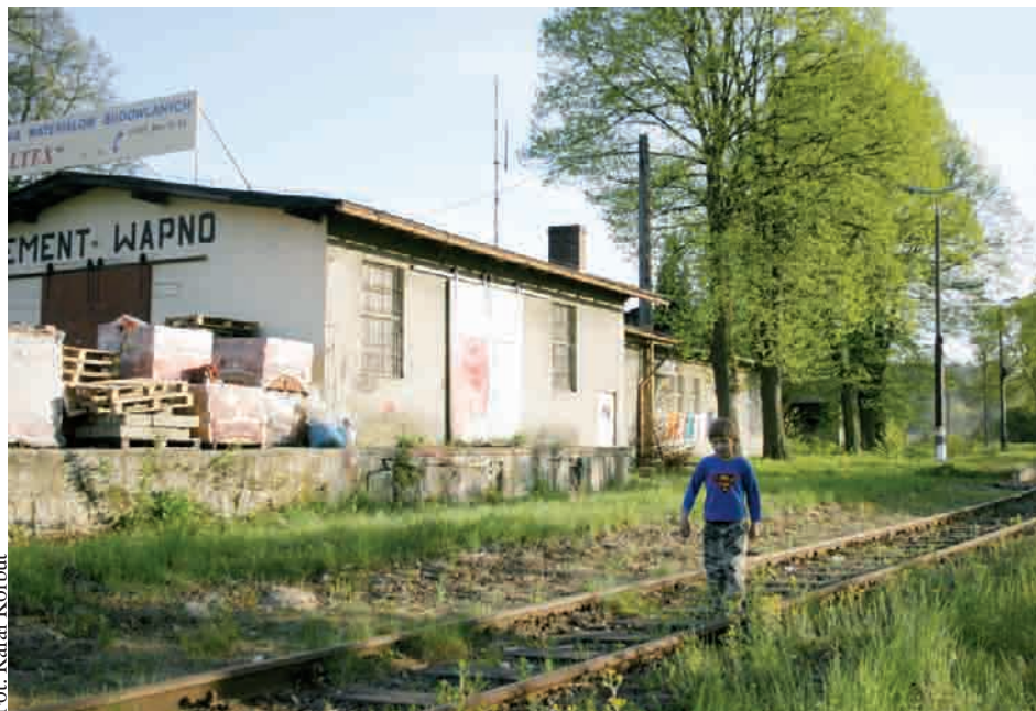
Dworzec w Żukowie
