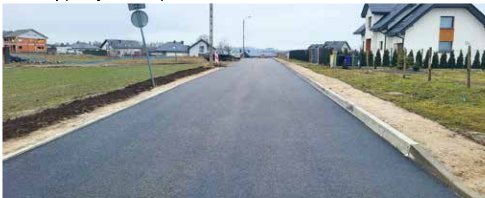
Prace remontowe przy ul. Spacerowej w Tuchomiu już na finiszu
