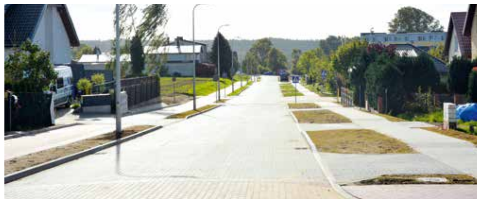
Wkrótce prace przy II etapie ul. Batorego oraz przy budowie ul. Heweliusza w Żukowie
