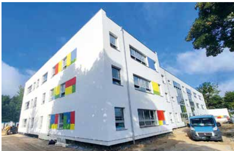
Rozbudowa szkoły w Baninie
