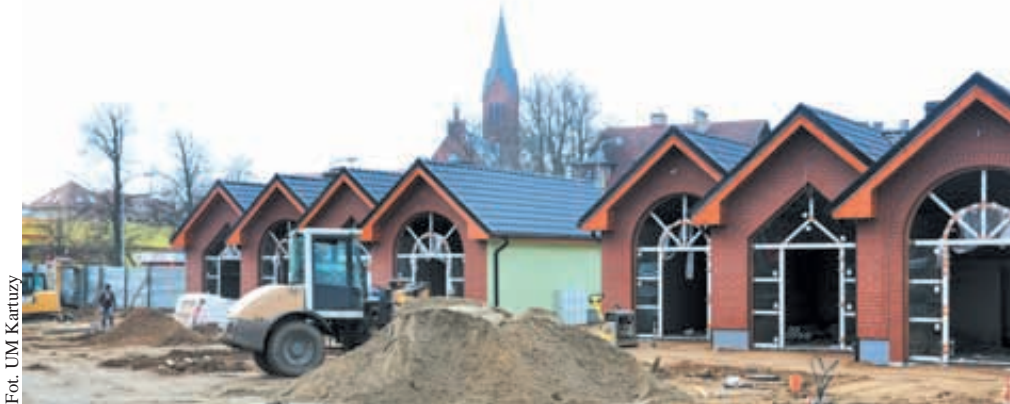
Prace przy budowie nowego targowiska są już bardzo zaawansowane
