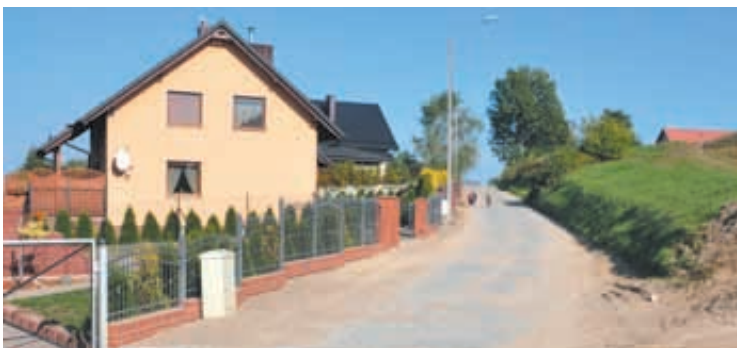
... oraz ułożono płyty na 11 drogach
