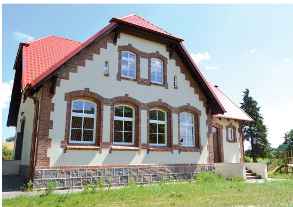
Wyremontowany budynek w Piotrowie
