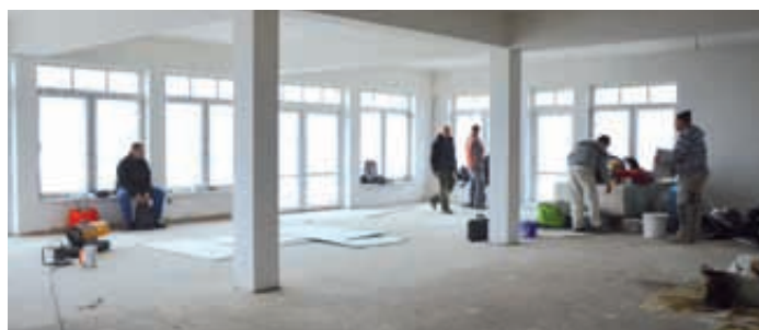
Prace budowlane idą zgodnie z przyjętym harmonogramem
