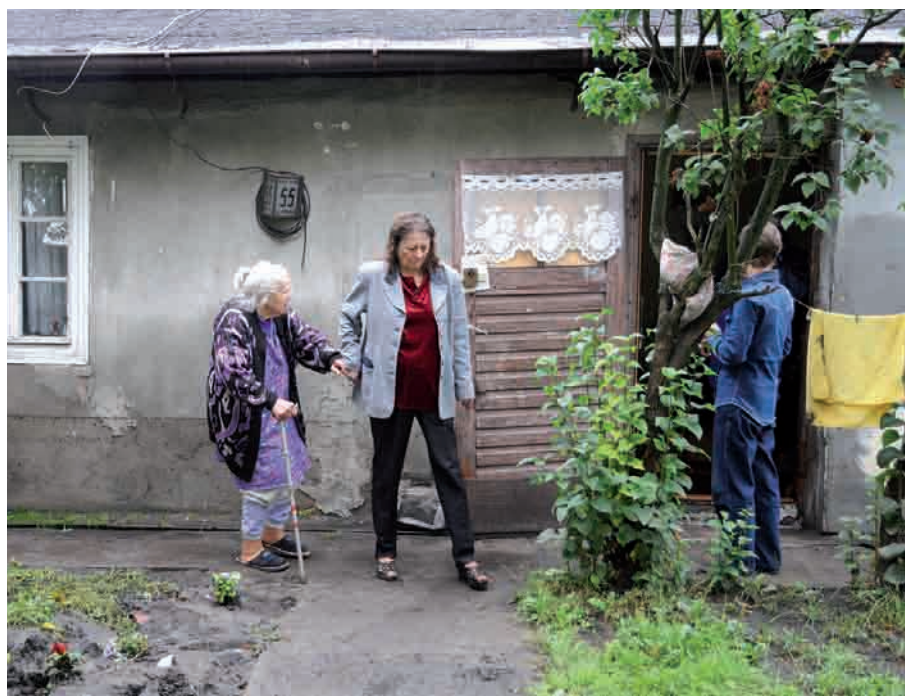
Woda w domu 91-letniej mieszkanki osiedla sięgała blisko pół metra
