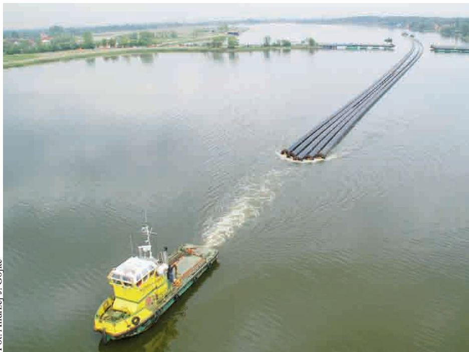
Operacja holowania rur do budowy kolektora głębokowodnego
