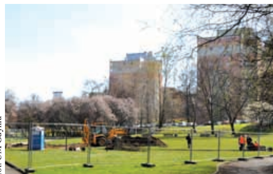
Prace budowlane już się rozpoczęły
